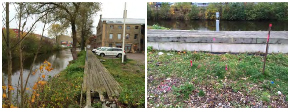
Foto 8 & 9. Befintlig kajkonstruktion av betongelement längs Mölndalsån. Foton tagna åt norr (vänstra) och åt väst (högra).
