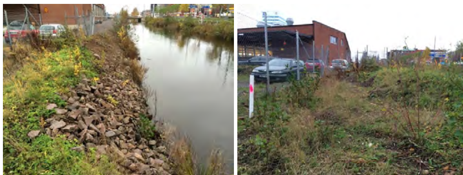
Foto 4 & 5. Erosionsskydd och översvämningvall vid planområdets sydvästra del. Foton tagna åt söder.
