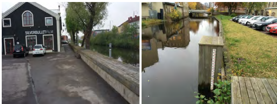
Foto 10 & 11. Befintlig kajkonstruktion av betongelement och kantskoning av tryckimpregnerade träpålar längs Mölndalsån. Foton tagna åt söder (vänstra) och åt norr (högra).
